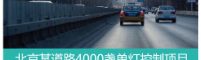
北京某道路4000盏单灯控制项目
