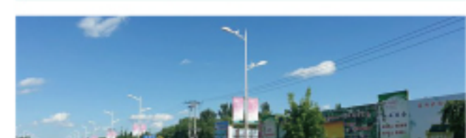
合肥市道路31500盏智能照明项目
